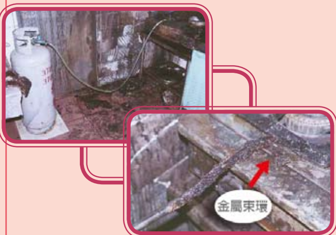
圖3 | 經勘查清理後發現連接爐具進氣口之塑膠軟管接頭受燒熔，另金屬束環受燒掉落。
