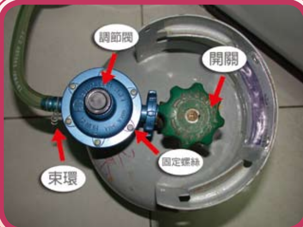
圖5 | 檢查瓦斯調節器、連接塑膠軟管金屬束環及調節閥固定螺絲是否鎖緊，不使用瓦斯時隨手將開關鎖緊。
