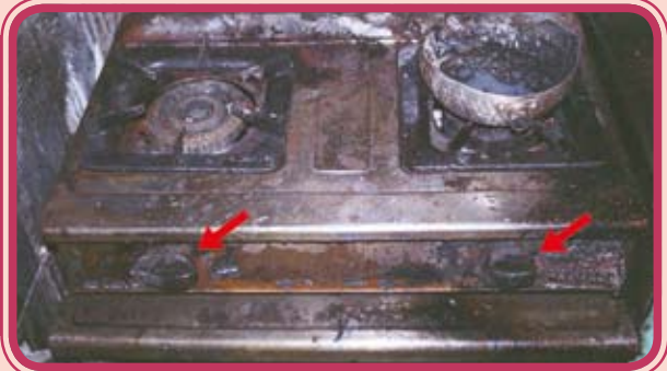
圖2 | 經檢視瓦斯爐受燒情形，發現黑色塑膠開關位於開啓位置，顯示火災發生前有使用爐火之行爲。
