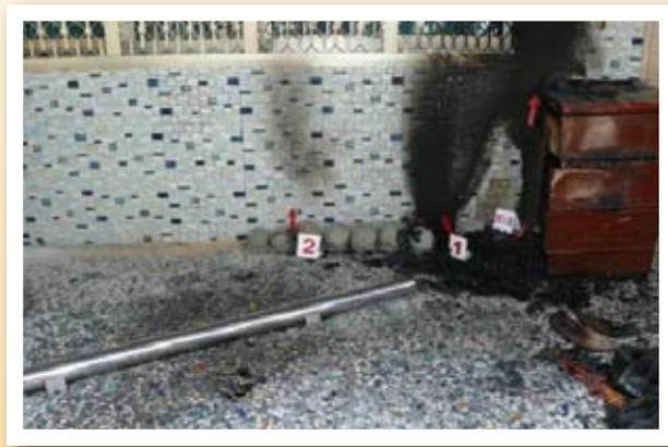
圖2 | 經消防局火災調查人員研判起火處位於塑膠鞋櫃處附近（塑膠鞋櫃已受火燒燬），且有兩處相距半公尺之不同火流方向之燃燒痕跡，並予以編號為1、2。
