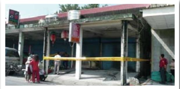
圖6 | 去（98）年9月15日2時54分前竹山鎮○○里○○街○號○○KTV發生火災，現場僅該○○KTV騎樓店面的兩扇鐵捲門下部輕微燒損，門口腳踏墊及大門邊柱面壁紙等燒損。
