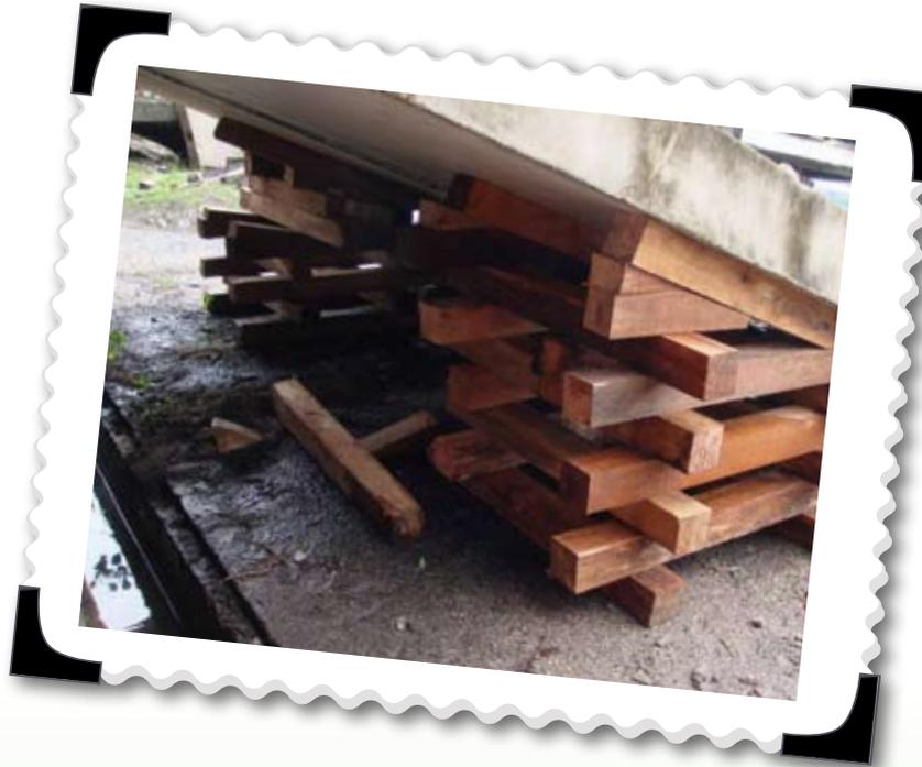
圖2 | 井字型支撐法 (適用於斜面的支撐)
