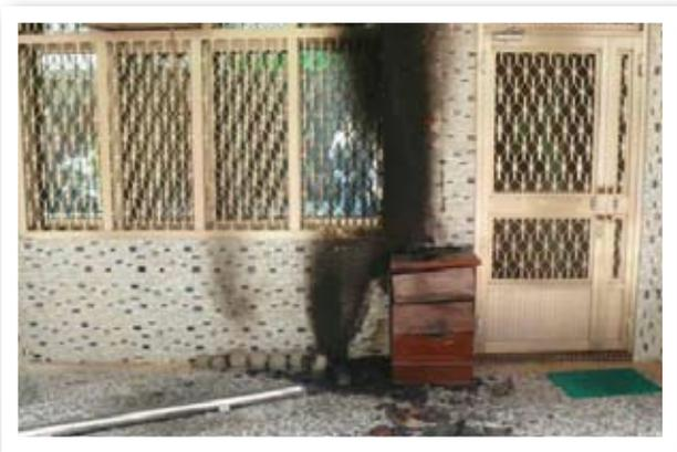
圖1 | 97年12月25日04時16分前竹山鎮一處住宅騎樓發生火災，現場僅該住宅騎樓塑膠鞋櫃受火燒燬、木製鞋櫃受火燒損及其後方磁磚外牆受火燒輕微剝落。
