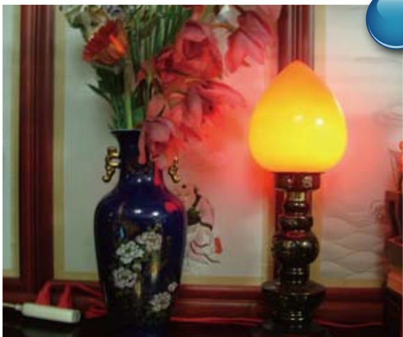
圖1 | 神明燈（應定期檢查，電線劣化時應予更換）。
