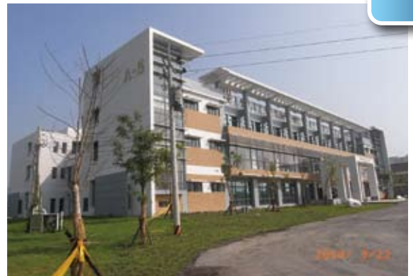
圖4 | 綜合大樓—植栽施作後。
