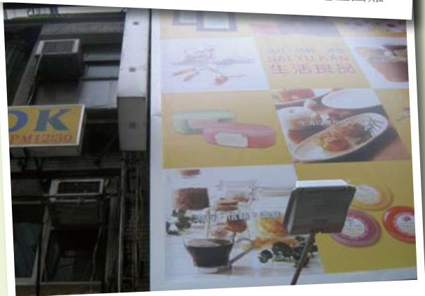
圖6 | 招牌封閉窗戶妨礙逃生救災。
