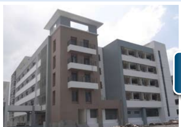
圖9 | 宿舍大樓--植栽施作前。
