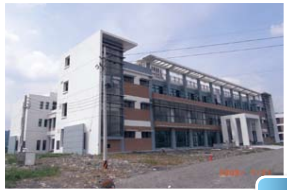
圖3 | 綜合大樓—植栽施作前。
