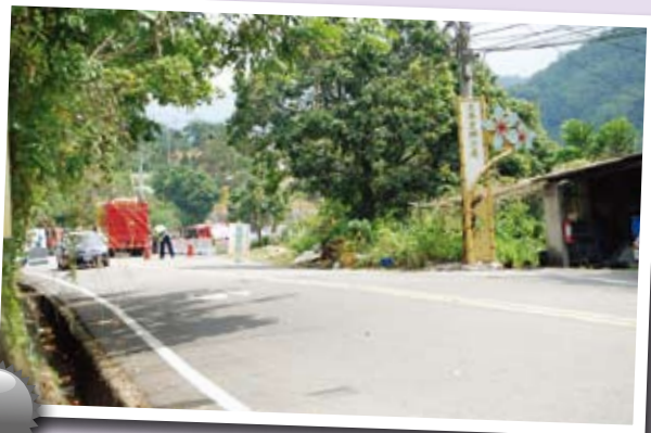
圖10 | 設置標誌管制通行。
