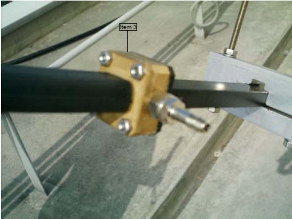
圖 2-3 可彎曲軟式導波管及導波管進氣轉接頭安裝
