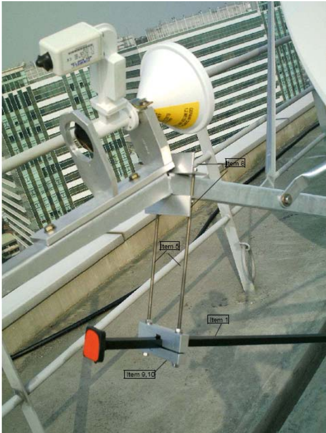
圖 2-2 硬式導波管安裝
