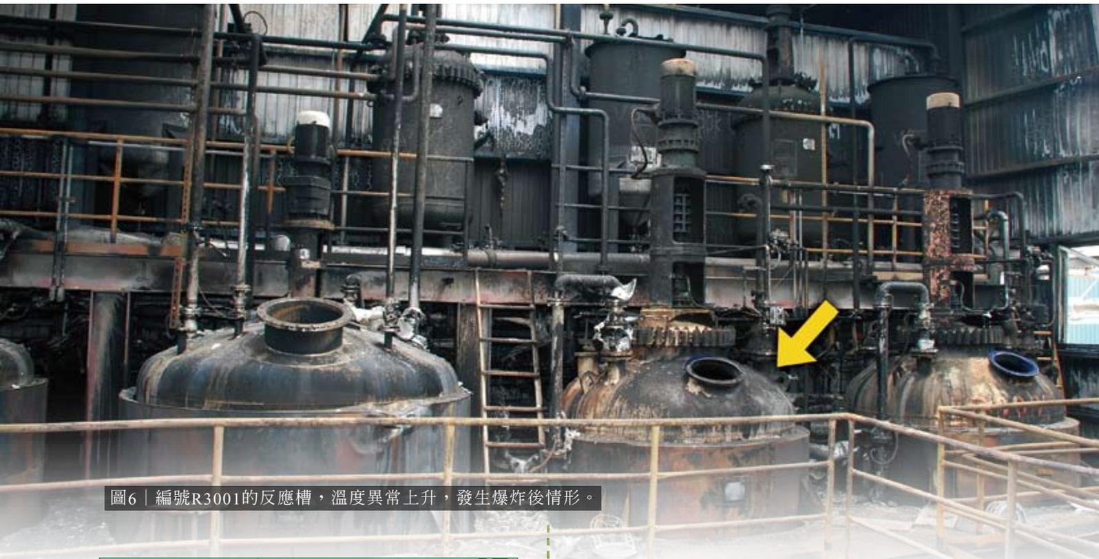
圖6 | 編號R3001的反應槽，溫度異常上升，發生爆炸後情形。
