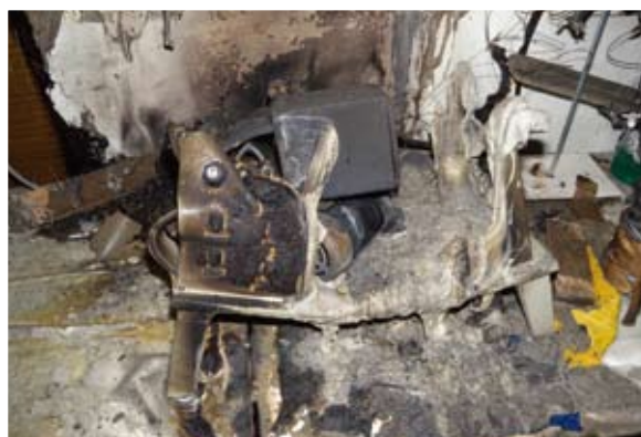
圖12 | 化鍍機後方上部燒毀嚴重。
