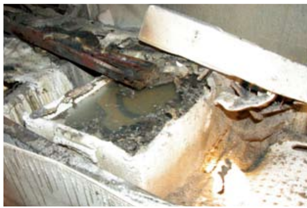
圖1 | 上方照明燈具掉落作業區，燈具右側生鏽嚴重。
