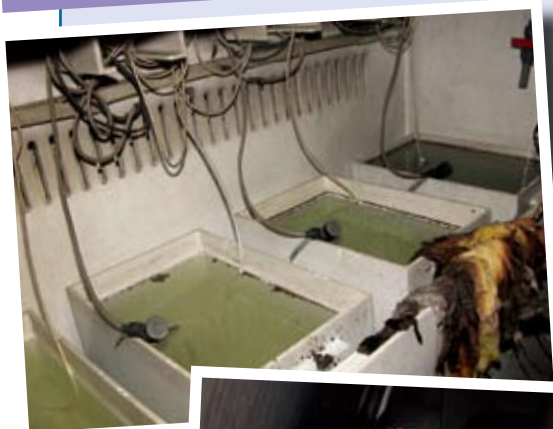
圖4 | 為燒毀酸槽作業區。
