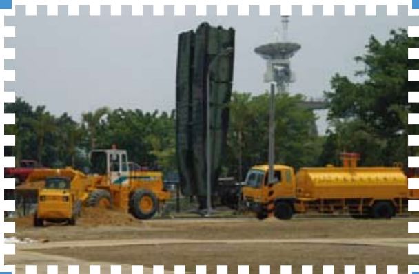
圖8 | 履帶機動橋架設及新化工務段搶修情形
