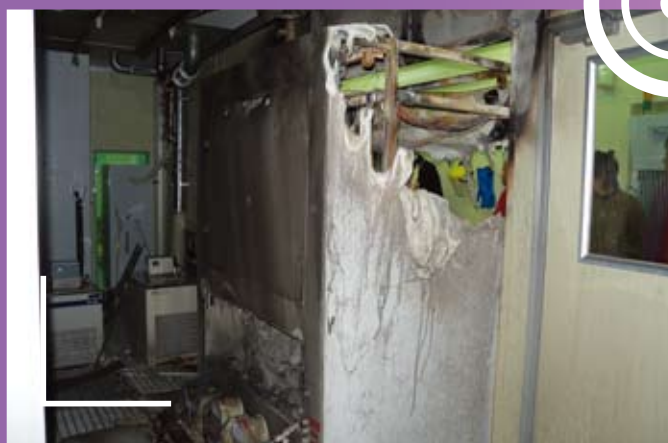
圖8 | 晶圓清洗機上方燒穿，燈具掉落。
