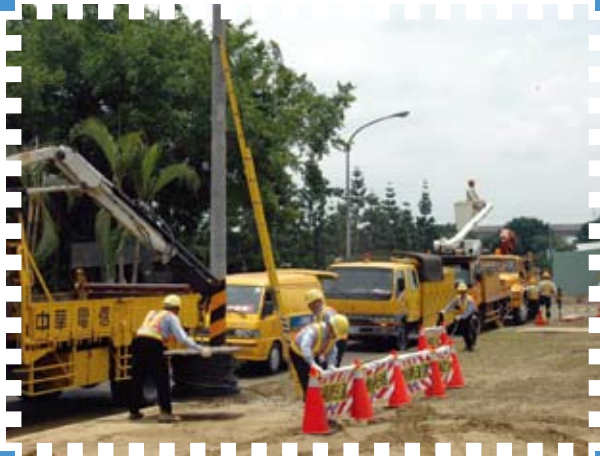
圖9 | 電力、電信等為生管線搶修情形
