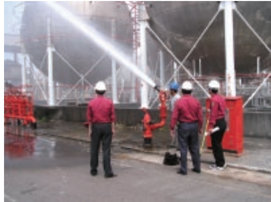
圖4-3-1 化工廠檢查情形
