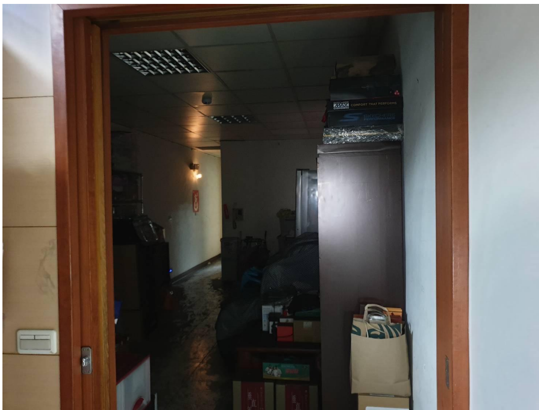
圖四：住警器裝設位置(3樓天花板)
