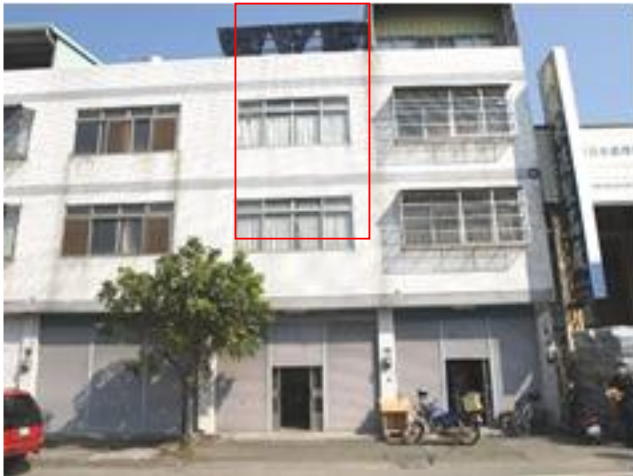
照片 1 建築物外觀完好未受燒
