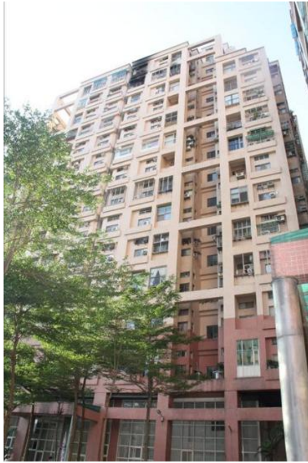
照片 1 建築物外觀受燒情形
