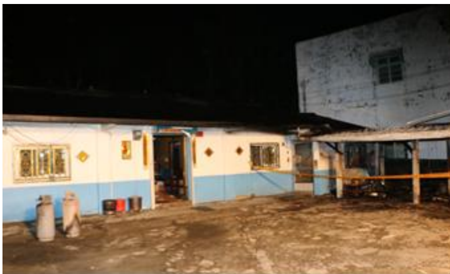
照片 1 建築物外觀受燒情形
