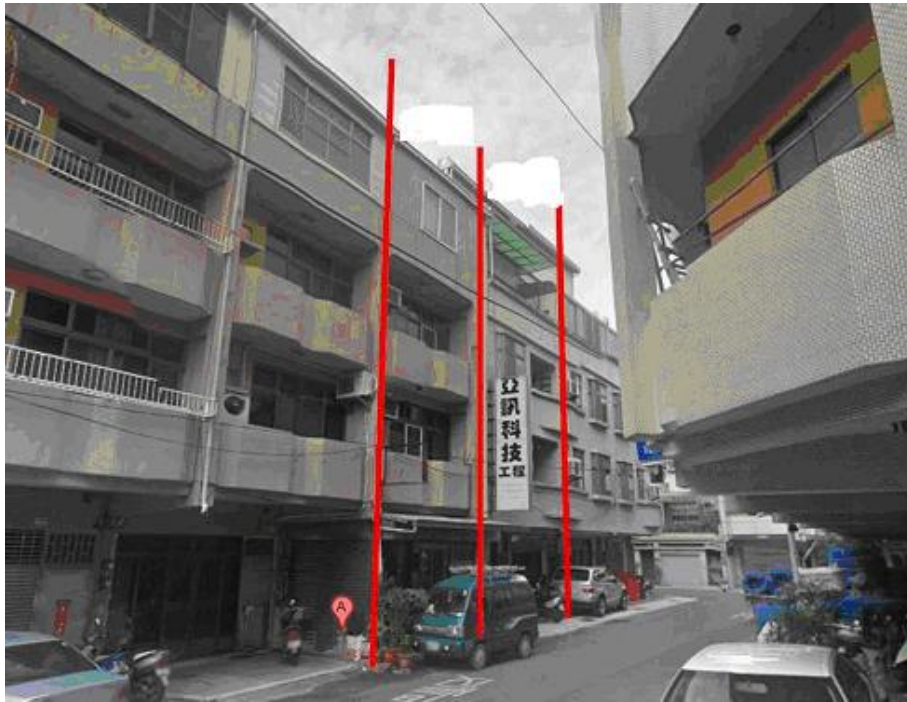
照片 1 建築物外觀受燒情形
