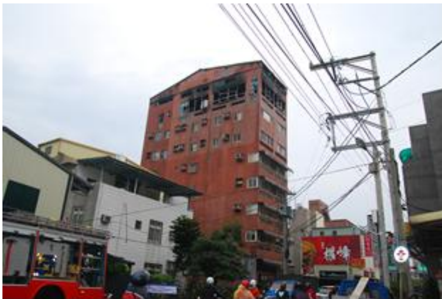
照片 1 建築物外觀受燒情形
