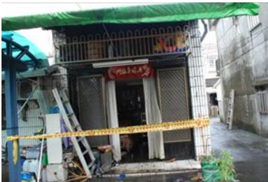
照片 1 建築物外觀受燒情形
