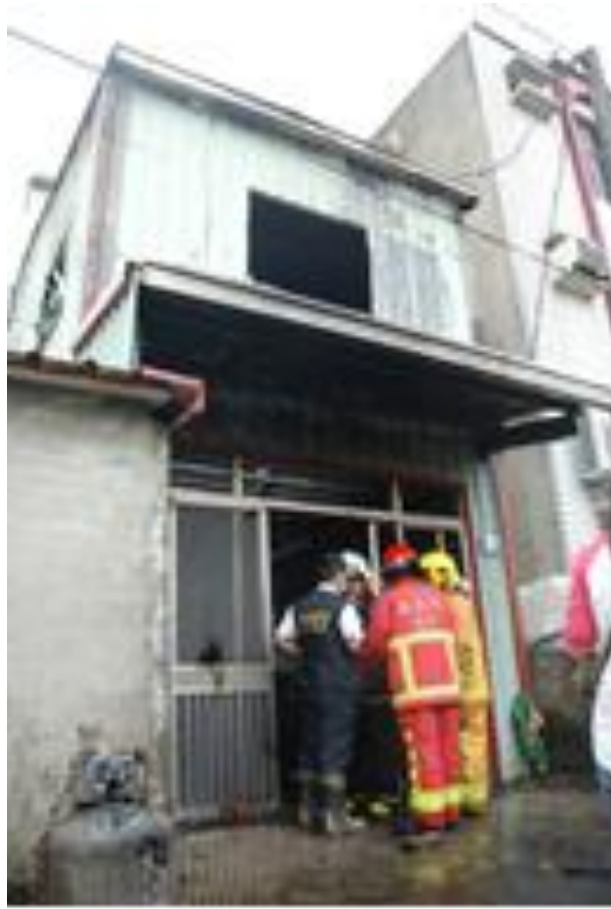
照片 1 建築物外觀受燒情形
