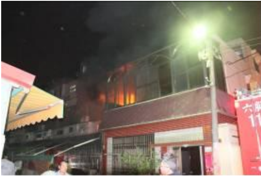
照片 1 建築物外觀受燒情形
