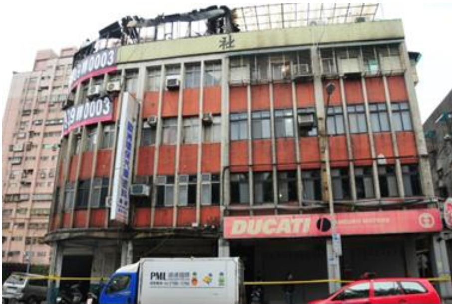
照片 1 建築物外觀受燒情形
