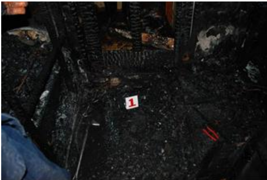
照片 2 室內受燒情形
