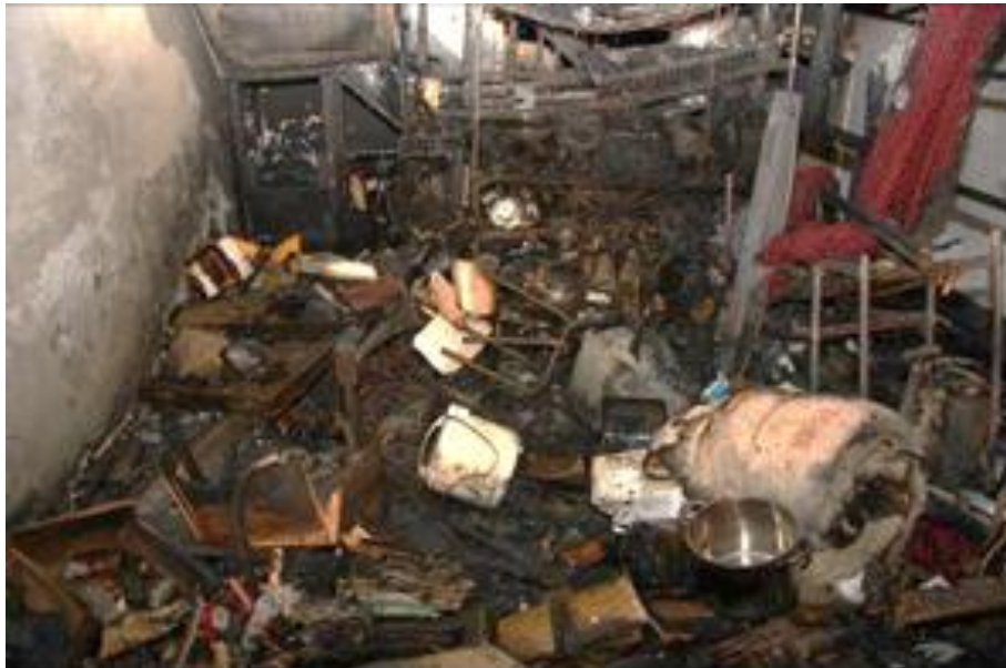
照片 2 室內受燒情形
