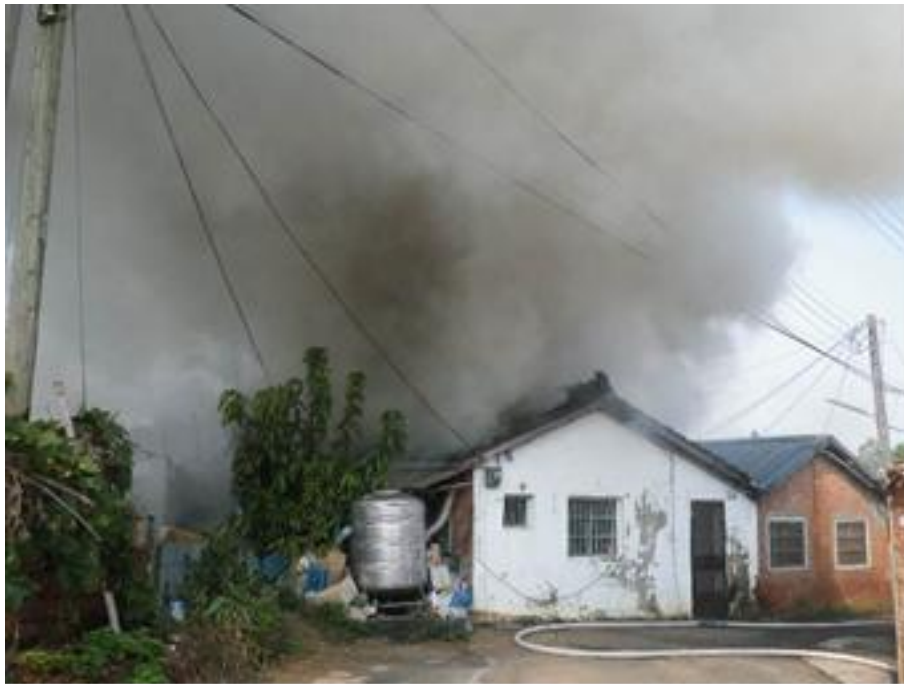
照片 1 建築物外觀受燒情形
