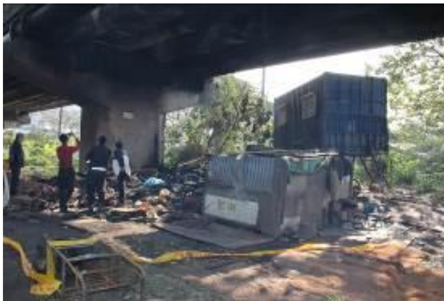
照片 1 建築物外觀受燒情形
