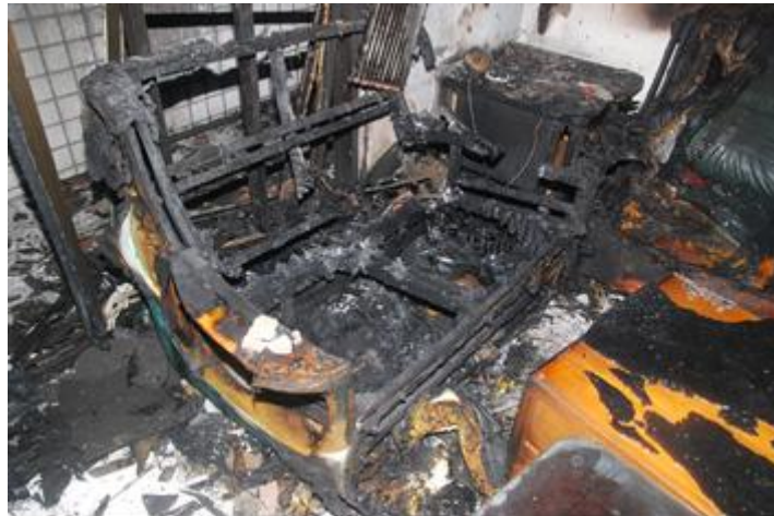
照片 1 建築物外觀受燒情形
