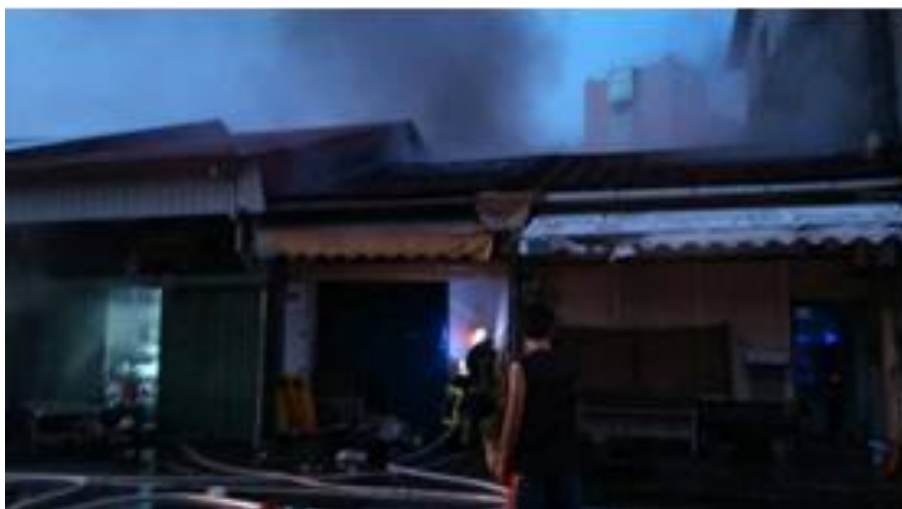
照片 1 建築物外觀受燒情形
