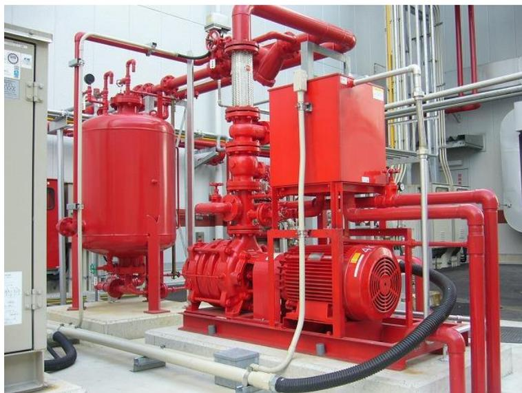
圖 2-27 加壓送水裝置（幫浦）與泡沫原液槽（資料來源：同註 1）
