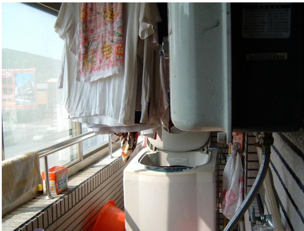
RF 式熱水器裝設於加蓋陽臺範例圖
