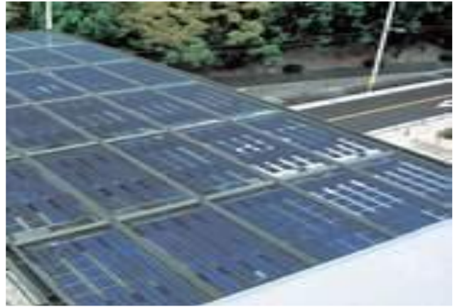
圖 3-4 建材一體型(Light through)
