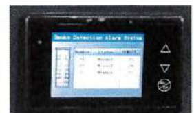
煙霧偵測主機
