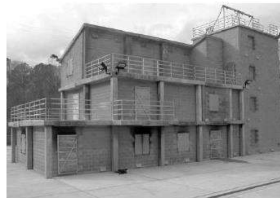
圖 A.7.1(f) A 類明火訓練設施和訓練塔。(弗吉尼亞海灘消防培訓中心提供，弗吉尼亞海灘，弗吉尼亞州。)
