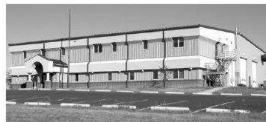
圖 C.2.1(d) 行政/教學大樓 (由懷俄明州夏延市夏延消防訓練中心提供。)
