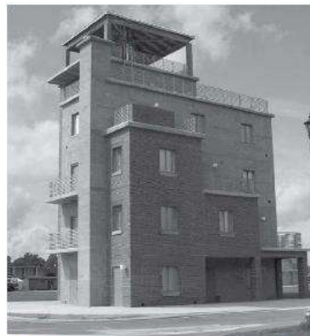
圖 B.5.1.1(b) 訓練塔 (由佛羅里達州塔拉哈西市塔拉哈西消防局提供)
