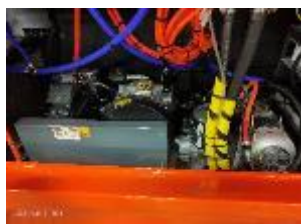
轉向油泵&氣壓泵
