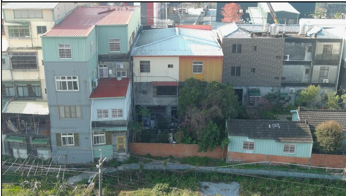
說明：建築物外觀照(北面)
