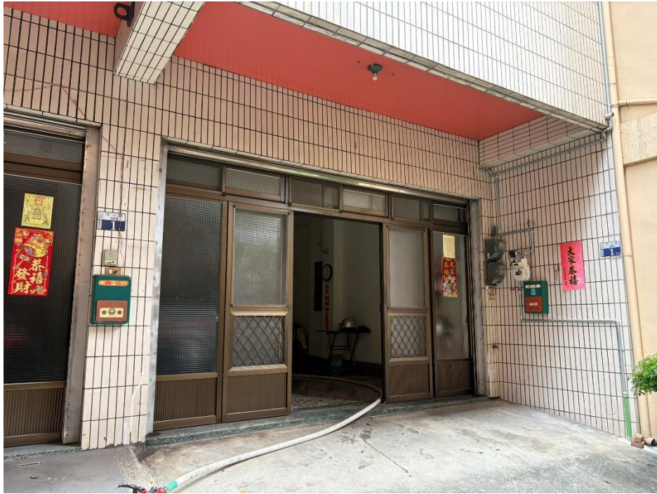
說明：現場佈線搶救情形。
