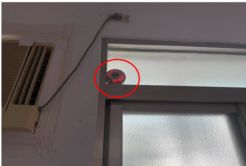
圖 2：住警器安裝位置及動作情形(已宣導民眾調整裝置位置)
