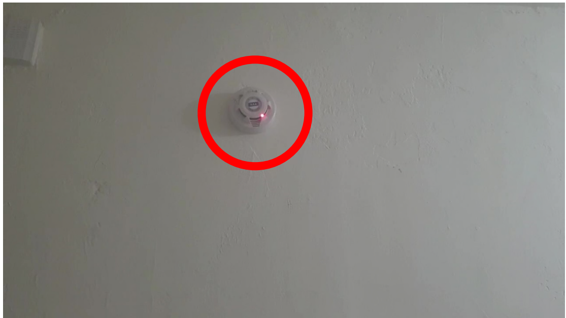
圖三：住警器安裝位置(客廳牆上)
