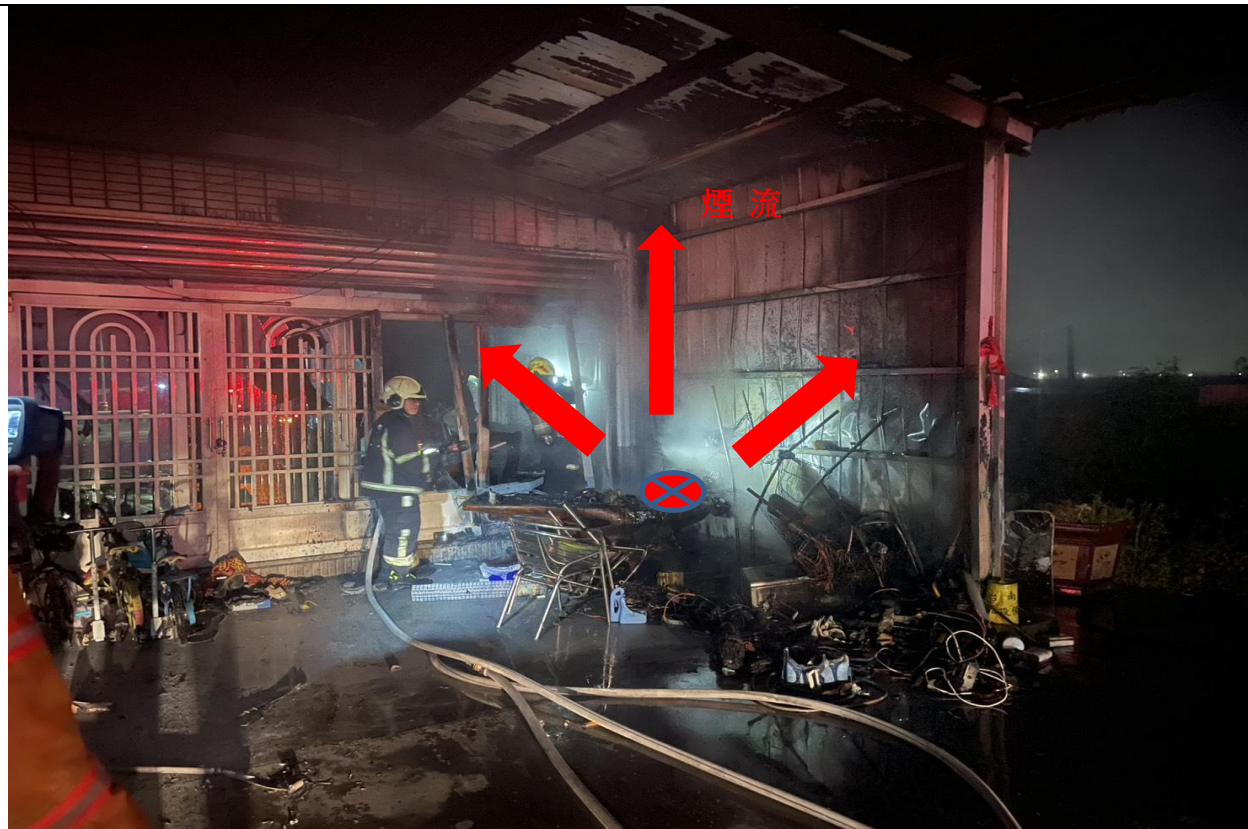
1樓車庫起火點及煙流照片
