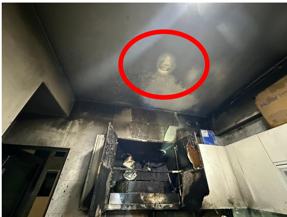
說明：住警器安裝位置(2樓廚房)
