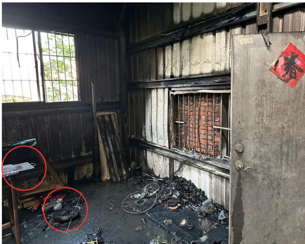
說明：建築物外觀照(北面餐廳外側)
