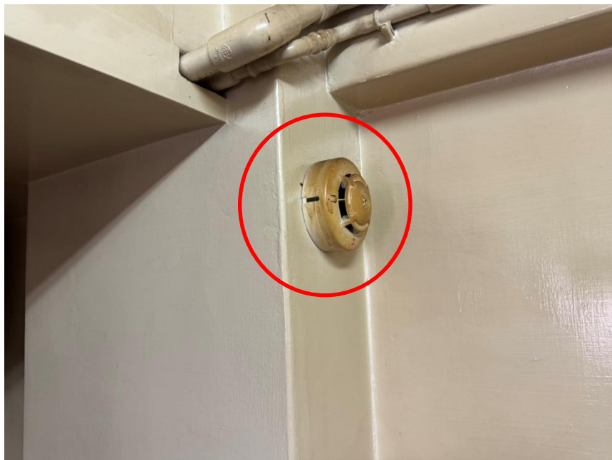
圖 2：住警器安裝位置及動作情形
