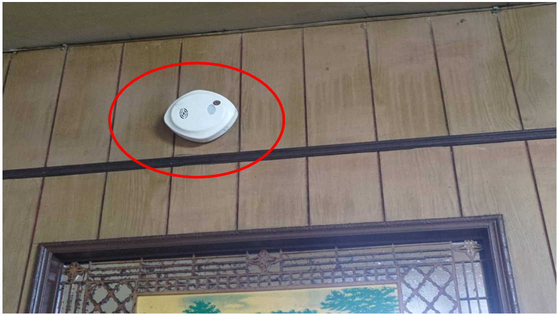
圖三：住警器安裝位置(客廳牆壁)
