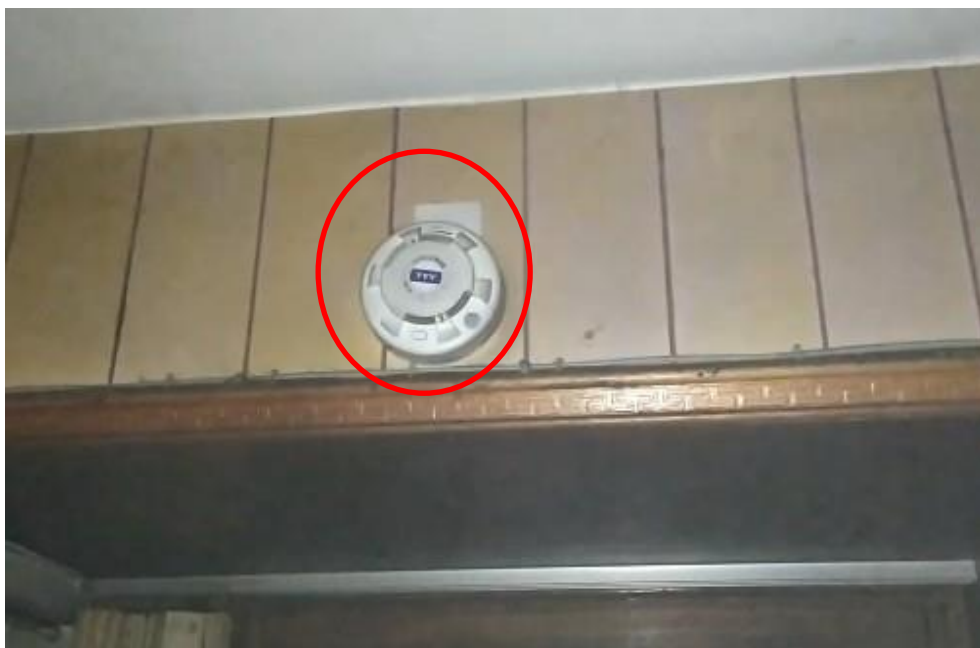
圖 2：住警器安裝位置及動作情形
