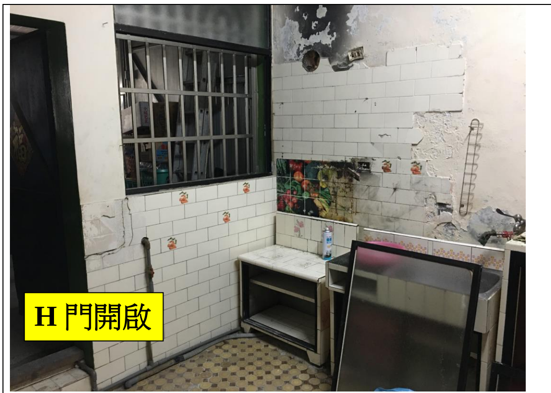
起火樓層開門、關門動作照片
